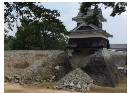
視察で訪れた熊本城の状況は…
