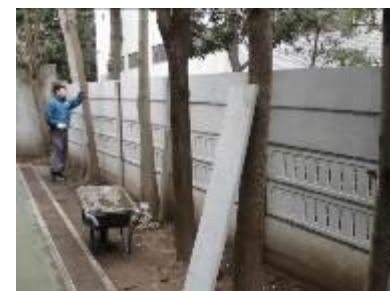
工事のお陰できれいな塀になりました
