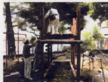
土台からしっかりと改修してもらいました
