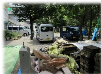
工事の様子。園庭には、業者の車が多数駐車していました。
